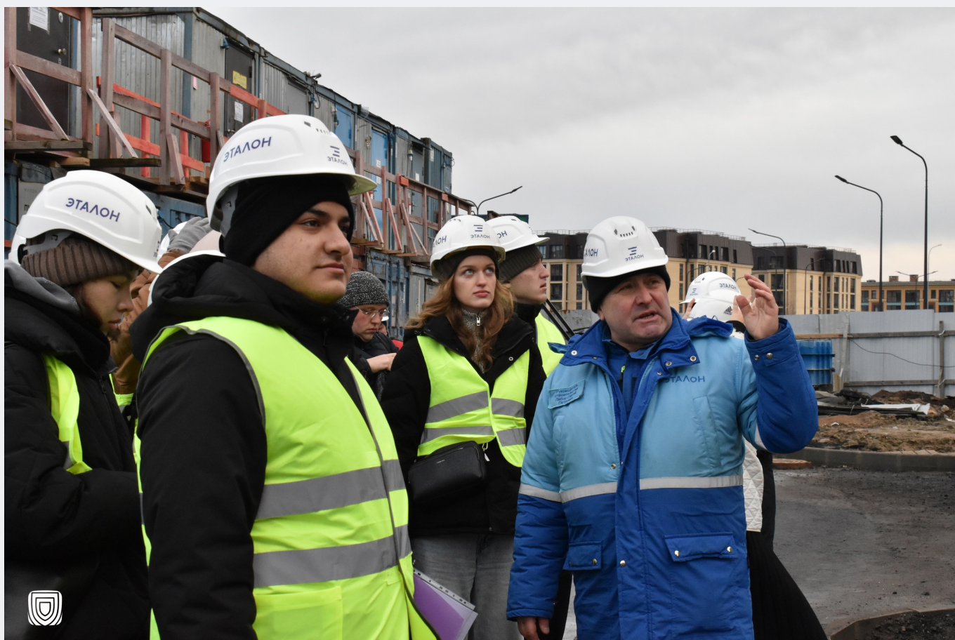
Сначала студентам провели вводный инструктаж, а после директор службы охраны труда и руководитель строительства АО ГК «Эталон» познакомили ребят с деятельностью компании и подробно рассказали про объект строительства, а также про
