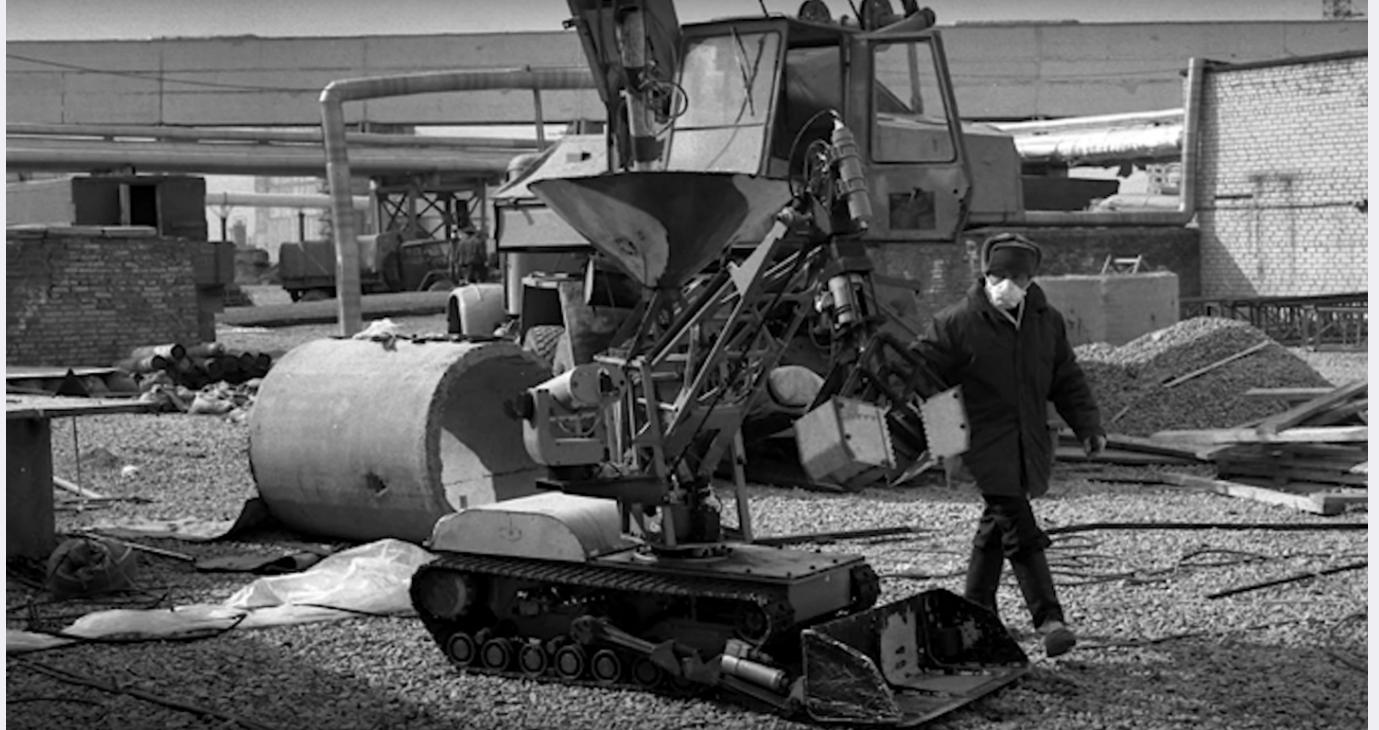
Всего ЦНИИ РТК для Чернобыля было создано около 15 специальных роботов. С их помощью с июня 1986 по апрель 1987 года было обследовано более 15 000 квадратных метров помещений внутри станции, кровли зданий и территории ЧАЭС, очищено 4 000 квадратных метров кровли зданий станции со сбросом радиоактивного мусора с частей взорвавшегося энергоблока № 4 в провал, образовавшийся на его месте, очищено 600 квадратных метров особенно сильно загрязненной территории так называемых «иловых полей».
